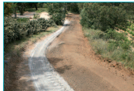
Epandage du liant hydraulique routier sur les pistes et chemins communaux.
