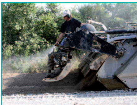
Le malaxage et l'arrosage permettent d'obtenir une structure homogène.
