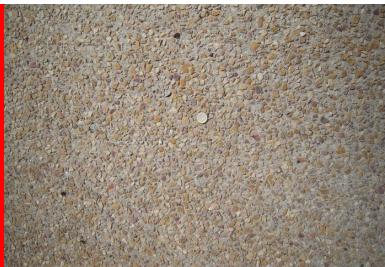
Rue de la République : trottoir en béton désactivé teinté.
