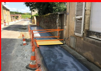
Rue de Beaune, Trottoirs en béton désactivé. A noter les passerelles pour assurer l'accessibilité et la protection du chantier.
