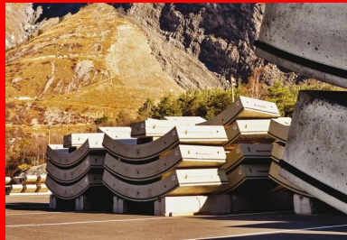
Sur un linéaire de 8 737 m de long pour à creuser, le tunnel atteint déjà plus de 4 000 m.
