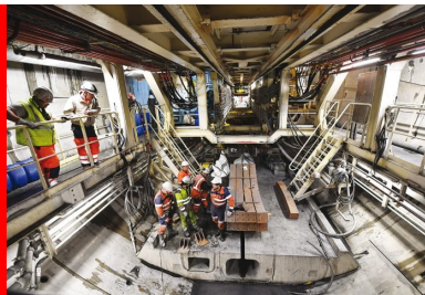
Travaillant 24 h/24, 7 j/7, le tunnelier « Federica » creuse et construit le tunnel à une cadence moyenne quotidienne de 13 m.
