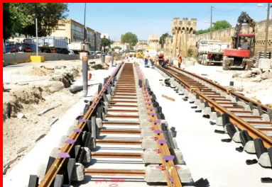
Les rails posés sur des traverses biblocs en béton, préfabriqués par Sateba. En gros plan, à droite, la partie sous patin de l'habillage des rails en mousse polyuréthane. Ces pièces (semelles élastiques) garnissent les rails avant le coulage du béton de calage. D'autres pièces viendront garnir les flancs du rail avant le coulage du béton de revêtement.
