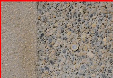
En gros plan, le béton désactivé intégrant deux types de granules : beige (6/16 S0V à 60 %) et noir (6/16 La Môle à 40 %).
