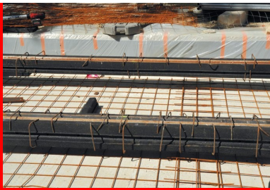
Deux rails en jaquette positionnés sur le béton de fondation, avec adjonction d'une nappe de treillis soudé, en attente du béton de calage.
