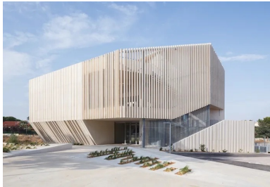
Pour renforcer l'image d'un cristal de roche équerrié, le bâtiment a été réalisé avec comme unique matériau le béton.
