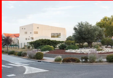
La façade nord est animée de percements traités comme des cadres de taille aléatoire.
