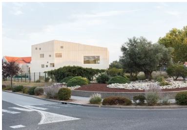
La façade nord est animée de percements traités comme des cadres de taille aléatoire.
