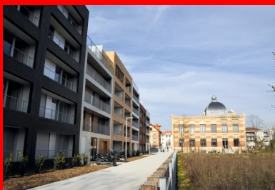
Vue générale du château de Nanterre. Au premier plan, les allées extérieures en béton décoratif réalisées entre mai et juin 2017.
