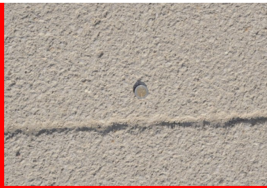
Le revêtement du parvis a été réalisé en Artcime® Boucharde
