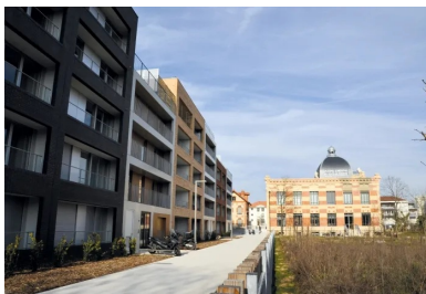
Vue générale du château de Nanterre. Au premier plan, les allées extérieures en béton décoratif réalisées entre mai et juin 2017.
