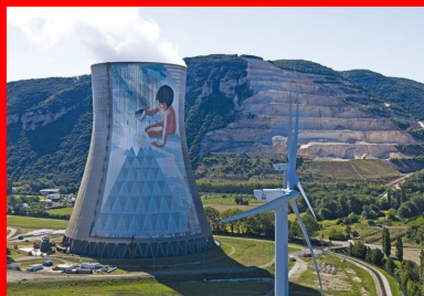
Jean-Marie Pierret - Le Verseau, 1991. Centrale nucléaire de Cruas. [©EDF-Cruas]
