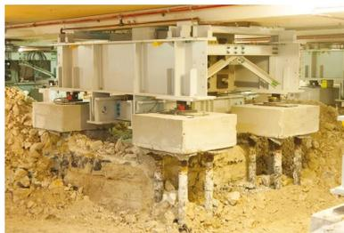
Le système de reprise en sous-œuvre consiste à transférer provisoirement les charges des poteaux vers des massifs de micropieux.
