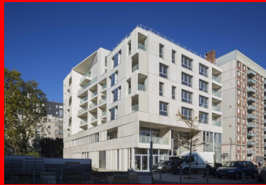
Le bâtiment et son épandage progressif avec, à droite, la barre voisine en R+10.
