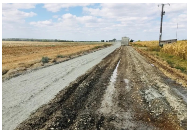
chantier de la RD7
