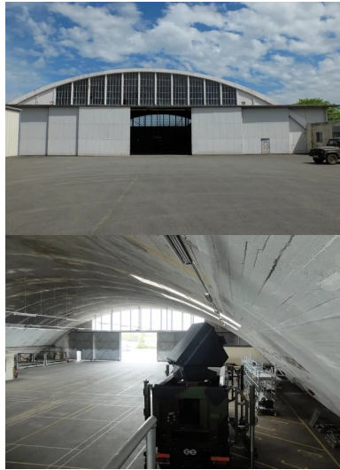
Vue du pignon ouest : les portes datent de 1945.
