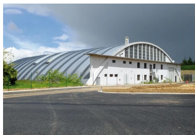
Vue du pignon est, muré par l'adjonction d'appentis intérieur.
