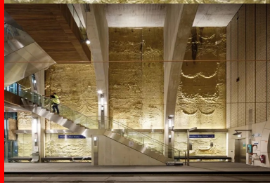
Paroi moulée et arches de soutènement, à l'entrée du tunnel. Le long, les bancs en béton blanc.
