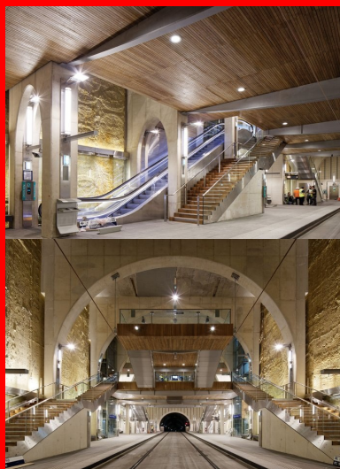
Système des arches évidées en diagonale pour les escaliers : les engravures des piliers accueillent les éclairages.
