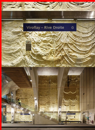
Parois moulées en béton apparent, puis teinté, avec les « draperies » de forage, une simple lame de verre protège la paroi.
