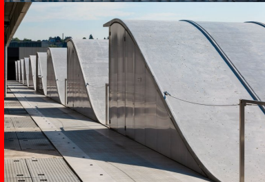
L'unité de post-dénitrification des eaux est desservie par une grande faille organisée entre les bassins de traitement et les locaux techniques intégrés sous une terrasse-jardin, une création originale de coques structurelles précontraintes et de nez résilles à base de BFUP se développe en couverture et en façade des bassins de traitement.
