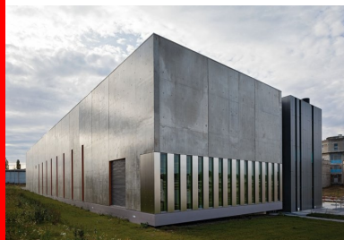
Unité de traitement des boues.
