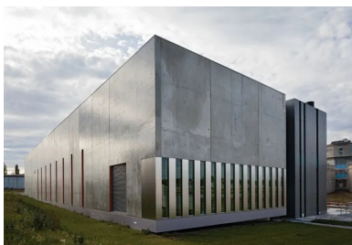
Unité de traitement des boues.
