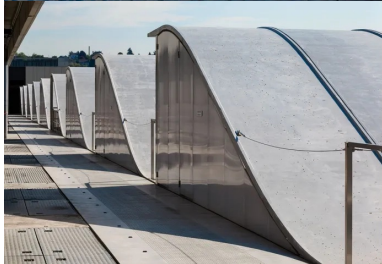
L'unité de post-dénitrification des eaux est desservie par une grande faille organisée entre les bassins de traitement et les locaux techniques intégrés sous une terrasse-jardin. une création originale de coques structurelles précontraintes et de nes résilles à base de BFUP se développe en couverture et en façade des bassins de traitement.
