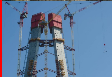
Au-delà, par un coffrage grim pant.
