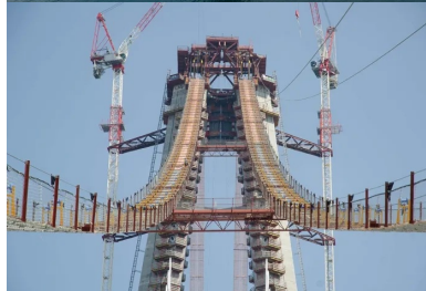
Les pylônes sont de section triangulaire variable...
