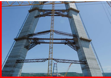
Les appuis, les travées de rive et les massifs d'ancrage sont en béton.
