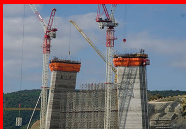
Ils sont réalisés jusqu'à 208 m de hauteur avec un coffrage glissant.
