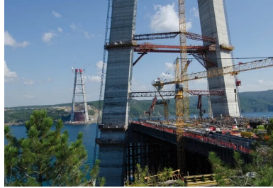
Le pylône européen est fondé sur la rive, non dans l'eau.
