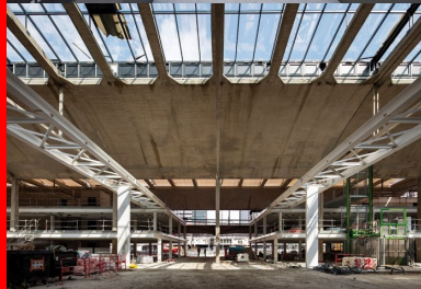
La halle est constituée de minces voûtes en béton (5 cm au faîtage) supportées par de fins piliers pyramidaux.
