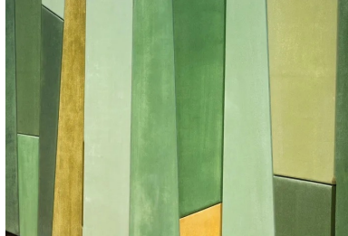
Gros plan sur le revêtement en « peau de sirène » des parements de béton.
