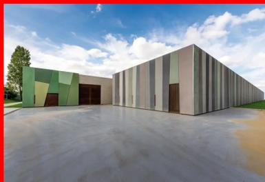
Angle nord-est du réservoir, quelques-uns des 356 panneaux de béton déclinés en 23 teintes.
