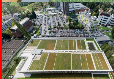
La toiture-terrasse, végétalisée en damier, et qui reprend les coloris des bétons de façades.
