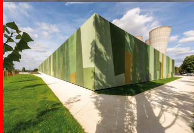
Parement cubiste en béton scintillant revêtu de millions de microbilles.
