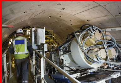
Pour améliorer le calendrier général du projet, deux tunneliers creusent simultanément des portions différentes du tunnel principal long de 5,8 km.
