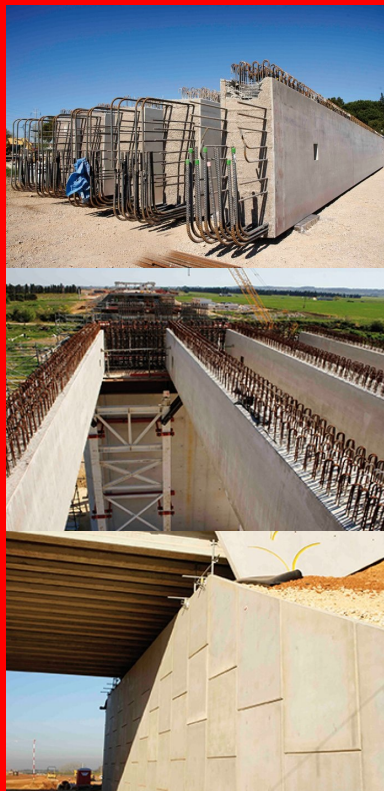
Les poutres préfabriquées en béton armé des estacades du viaduc du Lez et de la Lironde.
