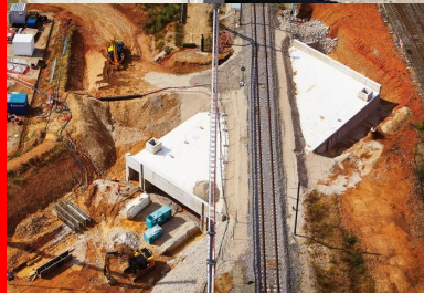
La dalle en deux éléments de la tranchée couverte de manduel (3 000 et 4 000 t) a été mise en place en 60 heures et 81 heures !
