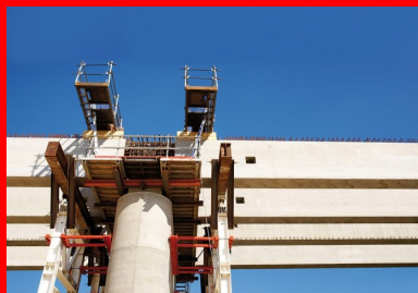
Quadripoutre en béton armé pour le franchissement du ruisseau de la Sarrelie et de la plaine du Vistre.
