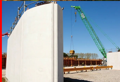
Une pile du futur viaduc (576 m) du Léz et de la Lironde.
