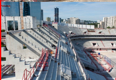
Gradins préfabriqués et portiques coulés en place.
