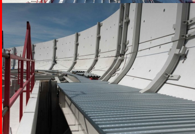
Détail du système d'accroche des coques préfabriquées.
