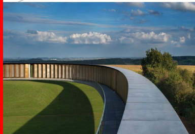
Le dimensionnement du périmètre - 328 m - est lié au nombre de noms et à une hauteur limitée.
