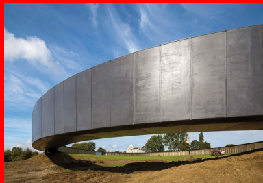
Il est posé en équilibre sur la ligne de crête, d'un porte-à-faux de 60 m.
