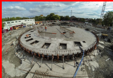
La dalle de couverture de la station.
