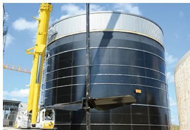
Phase de levage d'un agitateur pendulaire...
