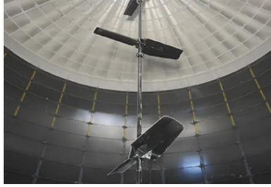
... pour brasser les effluents dans le digesteur.
