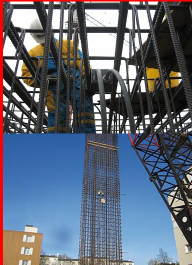
Chantier de la ligne b du métro de Rennes – intégration des tuyaux géothermiques : dans les piedroits, puis reliés à une pompe à chaleur
