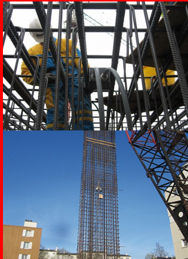
Chantier de la ligne b du métro de rennes – intégration des tuyaux géothermiques : dans les piédroits, puis reliés à une pompe à chaleur
