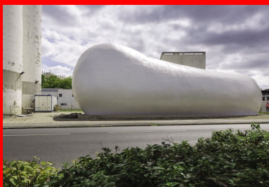
Vue de profil, partie émergée de la station de pompage réalisée en béton projeté.
