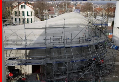
L'ensemble de la coque, en béton armé de 20 cm d'épaisseur, est nie manuellement à la taloche.
