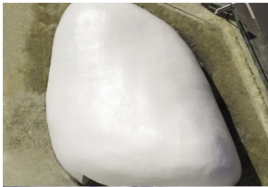
Vue aérienne : la forme totalement asymétrique et complexe de la coque est clairement visible.
