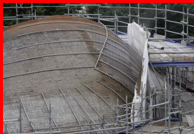
Ferrillage de la coque en béton armé, après la projection par l'intérieur, la projection par voie humide par l'extérieur peut débuter.
