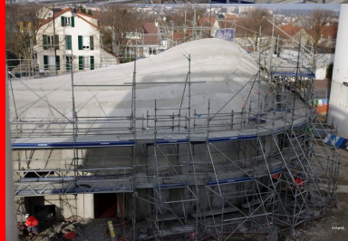
L'ensemble de la coque, en béton armé de 20 cm d'épaisseur, est fini manuellement à la taloche.
