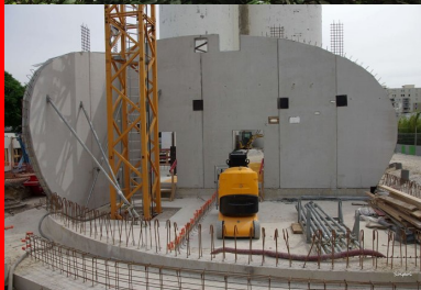
Prémurs arrondis en béton, d'une hauteur de 8 m épousant la coque en béton.
