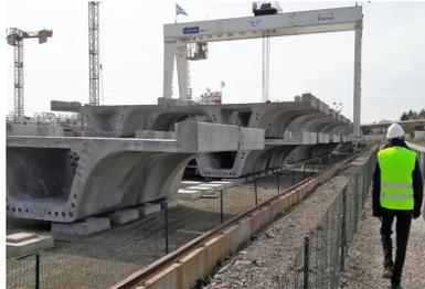
La maintenance des 973 voussoirs dans l'aire de stockage est effectuée par un portique mobile.
