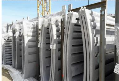
Les bandeaux de rives du tablier sont constitués d'une succession de 2 000 panneaux préfabriqués en béton fibré à ultra hautes performances.
