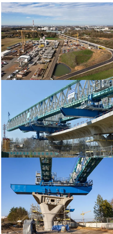
Tous les voussoirs sont préfabriqués dans une aire dédiée de 4,5 ha. Après maturation, les voussoirs sont acheminés jusqu'à leur lieu de pose en empruntant les parties de l'ouvrage déjà construites.
