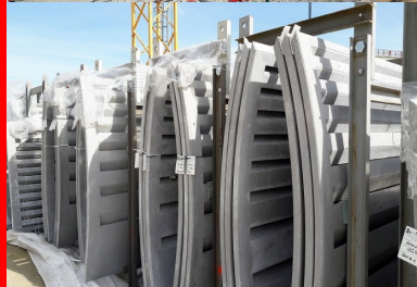
Les bandeaux de rives du tablier sont constitués d'une succession de 2 000 panneaux préfabriqués en béton fibré à ultra hautes performances.
