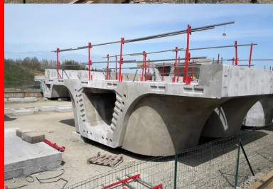
Chacun des voussoirs possède des caractéristiques et une géométrie uniques.
