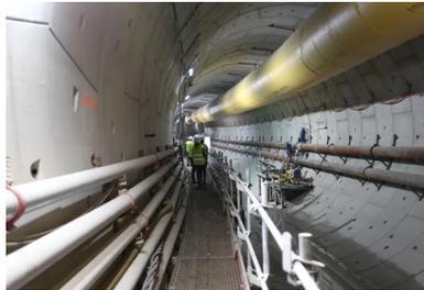
Intérieur du tunnel avec la conduite de marinage pour l'exfiltration des déblais et la canalisation de boue bentonitique.
