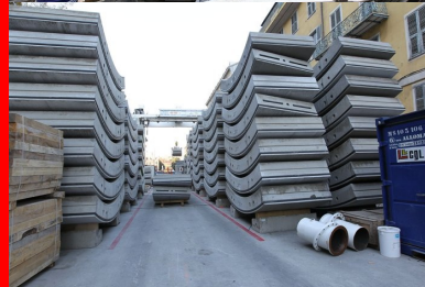
Rue Ségurane : sur la zone de chantier, stockage des voussoirs en flux tendu, en raison de l'exiguïté des lieux.
