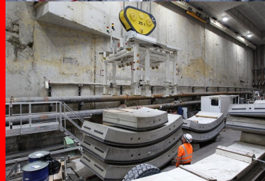
Puits d'entrée du tunnel, maintenance des voussoirs de 6 tonnes chacun.
