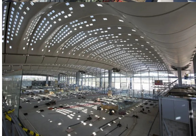
En sous-face, les coques habitent la structure et forment avec les palmes une surface à double courbure.
