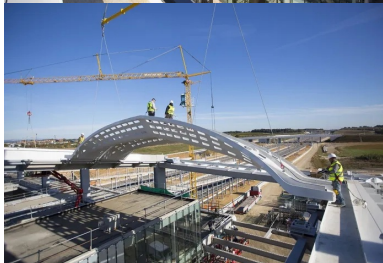
Elles sont mises en place avec une grue de 1 200 t et de 100 m de flèche.
