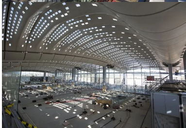
En sous-face, les coques habitent la structure et forment avec les palmes une surface à double courbure.
