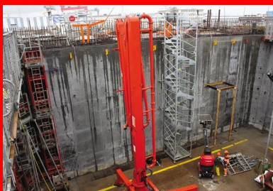
Le béton léger, autoplaçant est mis en œuvre par pompage.
