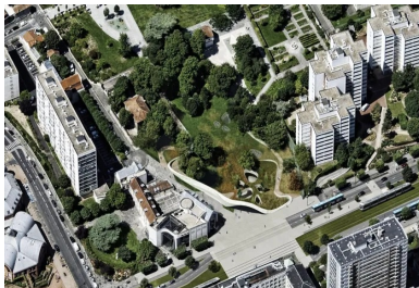
Végétalisée en toiture, la gare de Vitry prolonge le parc.
