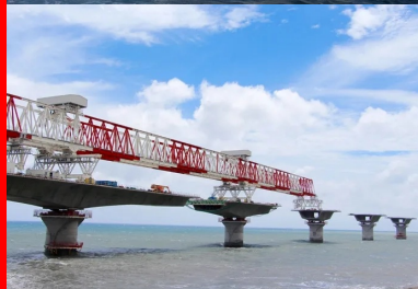
Appuyée sur les piles déjà en place, la poutre de lancement géante est capable d'assembler un fléau complet avant de se déplacer vers sa position suivante.
