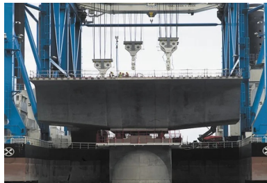
La barge zourite permet de transporter en une fois la tête de pile surmontée du mégavoussoir sur pile.
