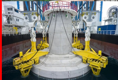
Les embases de 4 500 t sont posées avec une précision de 35 mm grâce à la barge zourite.
