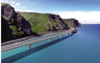
Long de 5,4 km, le viaduc forme des travées de 120 m et repose sur 48 piles en mer.
