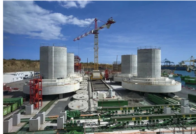
Les semelles de fondation cylindriques des embases de piles sont très massives : de 20 à 23 m de diamètre pour 4 m d'épaisseur.
