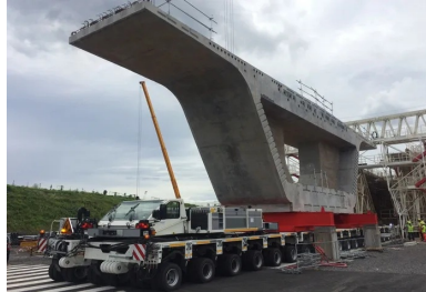
Les voussoirs sont acheminés depuis l'aire de stockage jusqu'à leur lieu de pose sur des fardiers munis de 216 roues !
