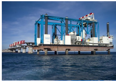
Zourite, la plate-forme automotrice, peut se stabiliser en se hissant sur ses 8 jambes d'acier. Les éléments de piles peuvent alors être installés dans des conditions équivalentes à celles de la terre ferme.
