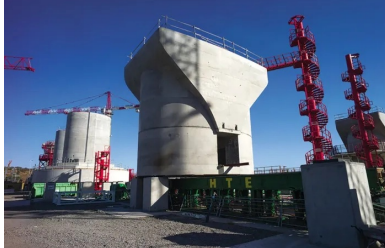
Les têtes de piles les plus lourdes pèsent jusqu'à 2 000 t.
