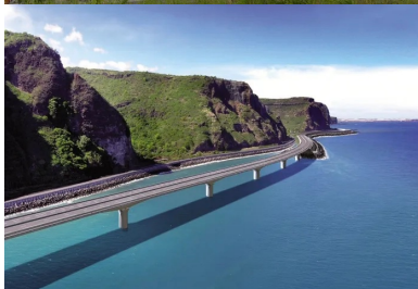
Long de 5,4 km, le viaduc forme des travées de 120 m et repose sur 48 piles en mer.
