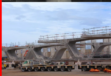
Stockage de voussoirs sur le site de pose. Le tablier est découpé en 1 206 voussoirs préfabriqués sur une aire dédiée de 9 ha à quelques kilomètres du chantier.
