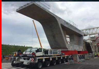
Les voussoirs sont acheminés depuis l'aire de stockage jusqu'à leur lieu de pose sur des fardiers munis de 216 roues !
