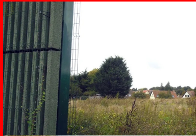
Montés seuls ou par deux, l'un sur l'autre, les panneaux protègent les zones résidentielles des tronçons où la circulation est la plus bruyante
