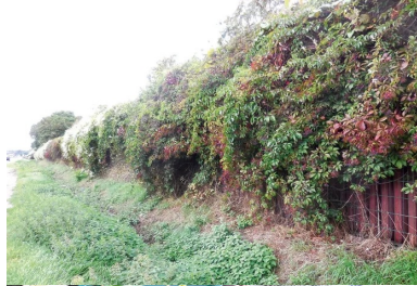
Réalisables en plusieurs couleurs (gris ciment, vert et, ici, rouge), les panneaux peuvent être végétalisés, jusqu'à être complètement dissimulés sous le feuillage.
