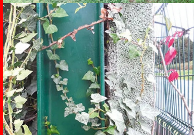
Des poteaux de soutien en forme de H maintiennent les panneaux d'un poids unitaire de 2,5 tonnes, qui sont rigidifiés grâce à une voile de béton de 10 cm, situé à l'arrière. Ils sont équipés de grilles anti-tags.
