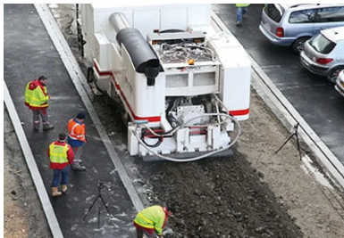
L'atelier de traitement ARC® 1000 en action dans le quartier des Sapins à Rouen. Il s'agit de sa première utilisation en zone urbaine.
