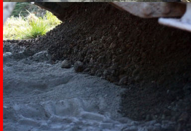
Traitement du sol
