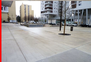
Trois types de bétons ont été retenus pour le revêtement de la place du Général-de-Gaulle : un béton brossé pour les zones piétonnes, un béton bouchardé, permettant le passage occasionnel de gros véhicules, et un béton hydrogommé pour la partie circulée de l'espace.
