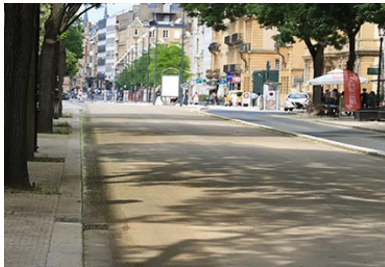
La couche de roulement a adopté différentes colorations selon le tissu urbain : couleur grise naturelle dans les nouveaux quartiers, basalte pour les carrefours et ocre-jaune teinté dans la masse en centre-ville.
