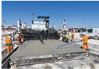
La Wirtgen SP-500 d'Agilis en action.
