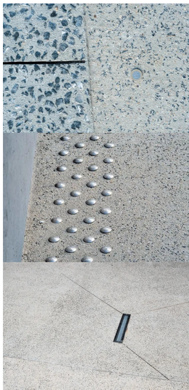
Zoom : deux bétons (C30/37) mis en œuvre par Sols Aquitaine.
