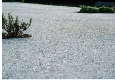
Le scintillement du béton tiré à la règle est obtenu par l'intégration en plusieurs passes d'éléments métalliques (3/6 mm) à raison d'un dosage très spécifique par mètre carré et d'une finition lissée à l'hélicoptère.
