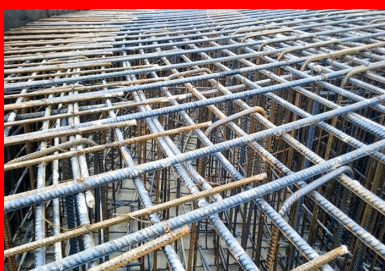
Mise en place du ferrailage par la Société d'armatures spéciales.
