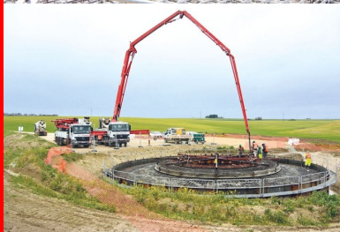
Opération de coulage du béton : le massif de fondation circulaire d'une E82/2300 mesure environ 9 m de rayon, soit 250 m 2 de surface.
