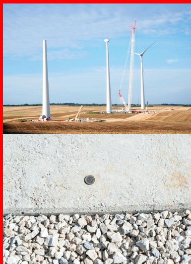
Des éoliennes E82/2300 en cours d'assemblage.
