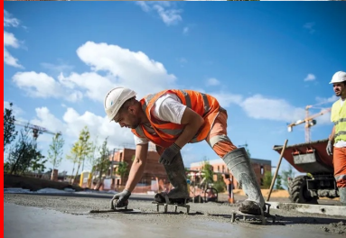
Après serrage, le béton frais a ensuite été finement taloché par des équipiers montés sur des chaussures à clous.
