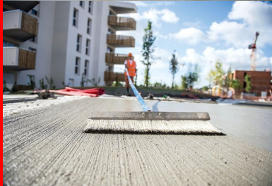
La surface du béton a enfin été animée par de fines stries régulières, réalisées au moyen d'un balai de marquage.
