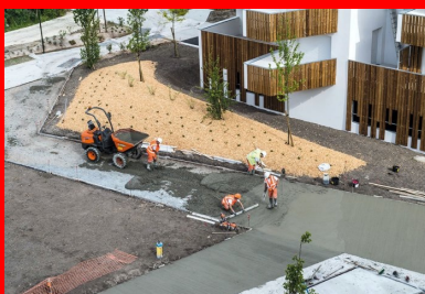
Acheminé sur le chantier par dumper, le béton a d'abord été tiré à la règle.
