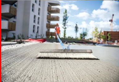
La surface du béton a enfin été animée par de fines stries régulières, réalisées au moyen d'un balai de marquage.
