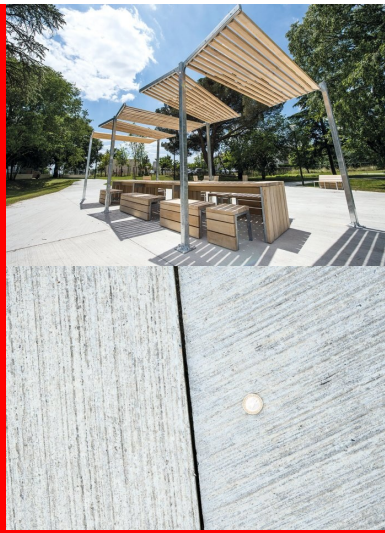
Les « stations vertes » des Sècheries : des aires de repos ou d'animation, dotées de mobilier et desservies par les cheminements en béton balayé.
