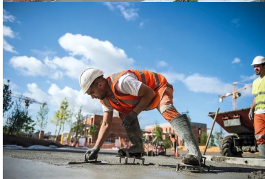
Après serrage, le béton frais a ensuite été finement taloché par des équipiers montés sur des chaussures à clous.
