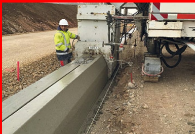
Mise en œuvre d'un caniveau à fente.
