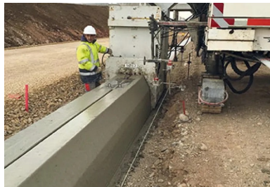
Mise en œuvre d'un caniveau à fente.
