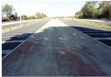
Pour accueillir les futurs clients du village des marques de Miramas, AER a réalisé les bordures des parkings en béton extrudé (17 cm de haut, 10 cm de large).
