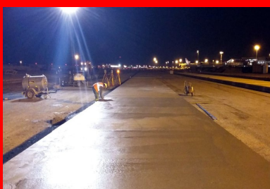
En vedette : le béton de roulement ER.
