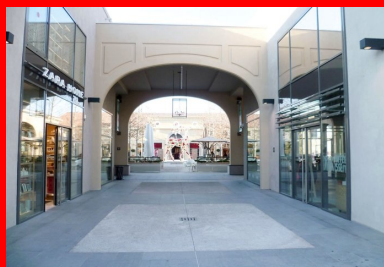
Au total, le béton micro-désactivé a été mis en œuvre sur une superficie de 1 702 m 2 .
