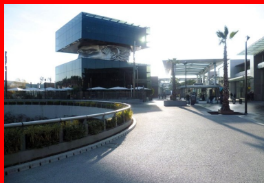
Les voies piétonnes et les parvis des magasins de Polygone Riviera ont été réalisés en béton micro-désactivé par la société MB Constructions.
