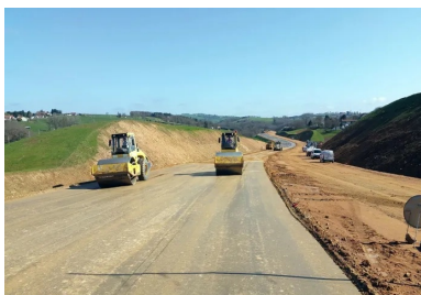
Le tronçon 2 x 2 voies sur 4,5 km implique la création d'une plate-forme de 25 m, qui nécessite environ 700 000 m 3 de terrassement. Au total, l'opération une fois achevée se soldera par le traitement de 115 000 m 2 de couche de forme au liant hydraulique routier.
