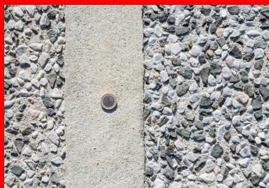
le béton désactivé (à droite du gros plan) intègre deux granulats - un 10/14AC Gris des Pyrénées et une diorite de Thiviers (Périgord)
