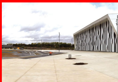
70 % des 10 000 m 2 de surface réalisée ont bénéficié d'un revêtement en béton sablé.
