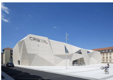
L'implantation sur plusieurs niveaux du complexe cinématographique a permis de libérer une vaste place à l'avant de l'équipement
