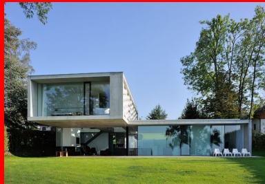
Le premier étage s'élance en direction du lac par un généreux porte-à-faux.
