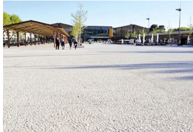
/ Vue générale de la place Jules-Morgan. Au premier plan, le béton de granulométrie 20/40
