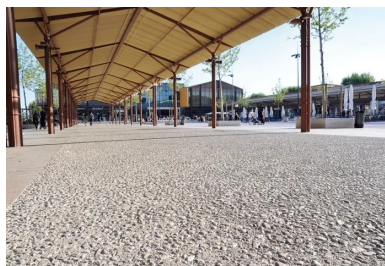
Sous la halle couverte, le béton de granulométrie 20/40 accentue l'aspect minéral de la place.
