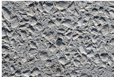
Le béton squamé intégrant des granulats concassés de calcaire clair 20/40.
