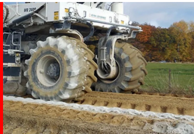
Spécialement dépêché de Woippy, près de Metz, le malaxeur Wirtgen WR-2400 d'Eurovia entre en action.
